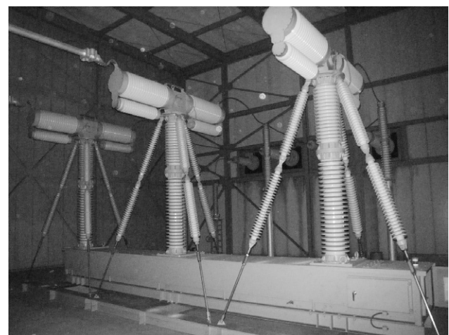
Fig. 3 168kV VCB
